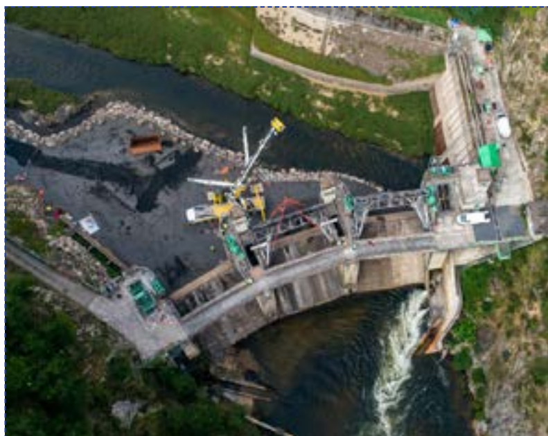
Vue aérienne du barrage de Poutès en cours de modification https://www.oxygenedrone.com/article-30/travaux-de-dementellement-du-barrage-de-poutes/
