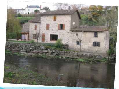
Abaissement de la ligne suite à un arasement d'ouvrage à Parthenay (79)
